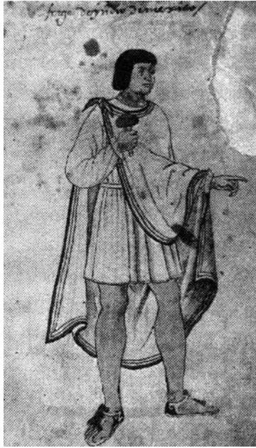
FIGURA 9. Vestimenta a lo romano
