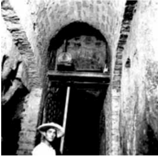
Foto 2. Galerías filtrantes de Guadalajara, 1949
