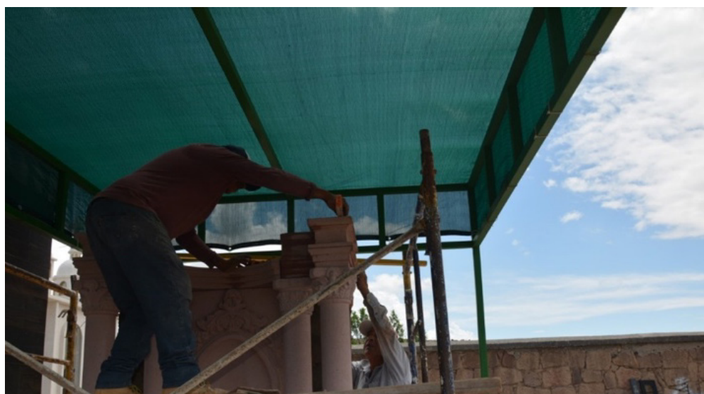
Figura 5. Instalación de piezas en el panteón de Escalerillas
