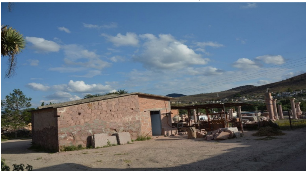
Figura 2. Viviendas dotadas a las familias reubicadas donde se construyó la presa Gonzalo N. Santos (el Peaje)
