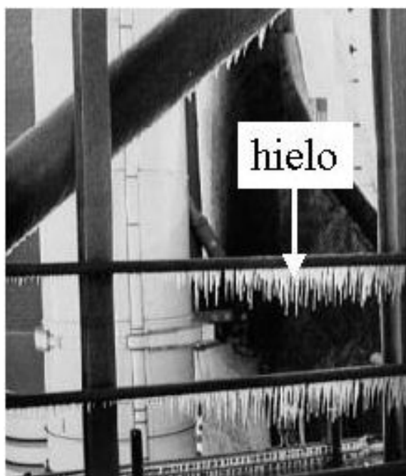
FIGURA 10. Rampa de lanzamiento del trasbordador Challenger, donde se puede observar la presencia de hielo.
