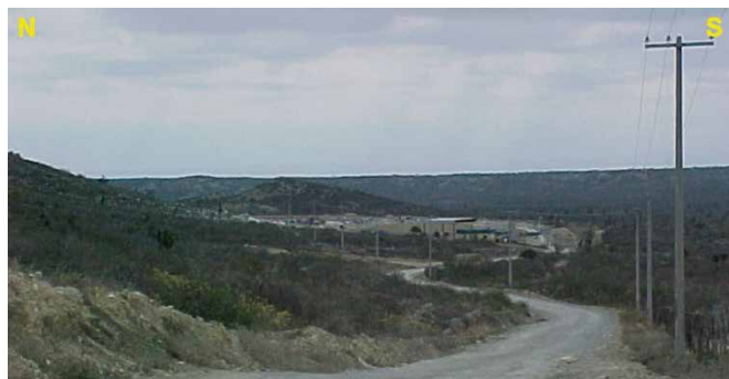
Figura 8. Sobrevista del relleno sanitario municipal, Linares, N.L.
