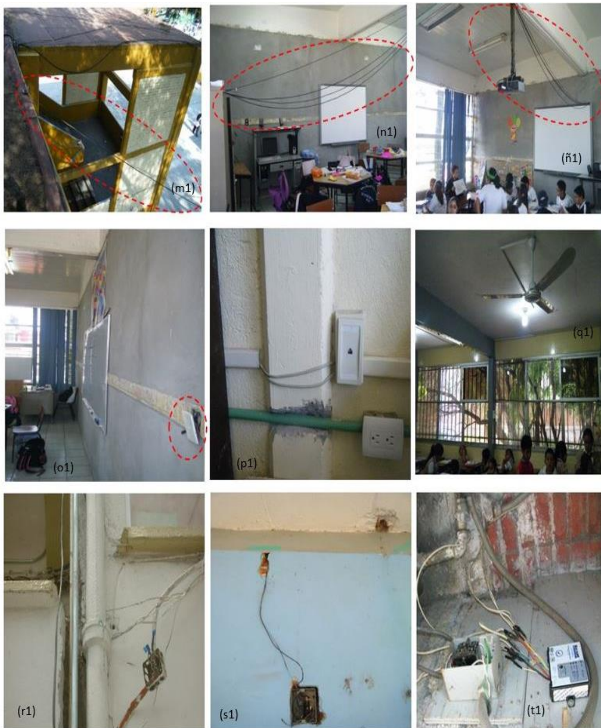
Figura 18. Carencia total del mantenimiento eléctrico en las instalaciones tanto en educación primaria como en secundaria. Imágenes (m1), (o1), (p1) de Hidalgo, imágenes (n1), (r1), (s1), (t1) de la Ciudad de México, e imágenes (ñ1), (q1) de Tlaxcala.
