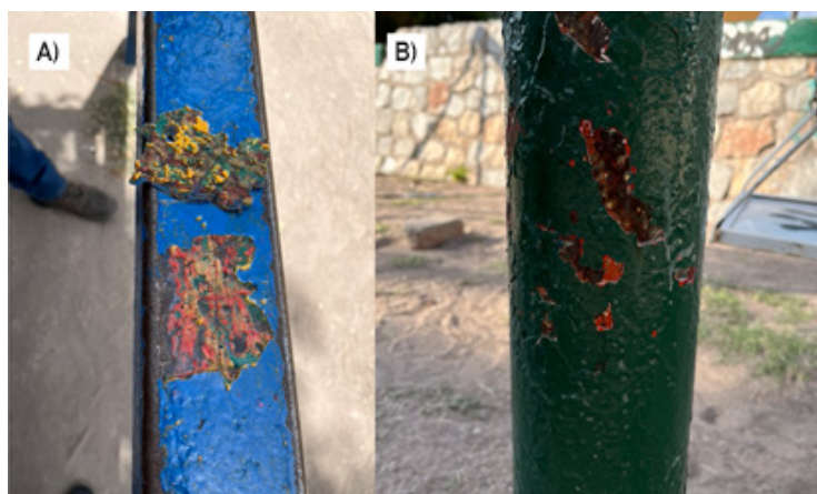
Fig. 1. Diferentes capas de pintura de varios colores pueden encontrarse en una misma estructura. La figura (a) corresponde a la plaza Primero de Mayo y la figura (b) corresponde a la plaza Manuel Acuña.
