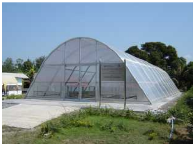
Figura 1. Secador solar tipo invernadero diseñado por Janjai (2012) para industrias a pequeña escala.
