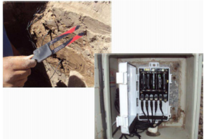
Figura 2. Sensor de humedad del suelo 10HS Decagon Device instalado en lote experimental para calibración del modelo integral.
