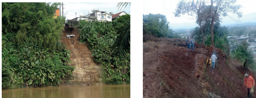
Figura 11. Remediación y fortalecimiento de taludes mediante el uso de plantas vetiver en la parroquia 24 de Mayo y el centro de Quevedo.
