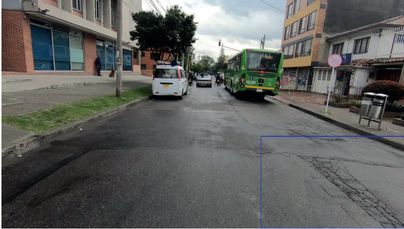
Figura 8. Piel de cocodrilo en una vía de la ciudad de Bogotá, Colombia.
