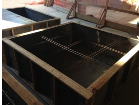
Figura 1. Formas para vaciados das paredes.
