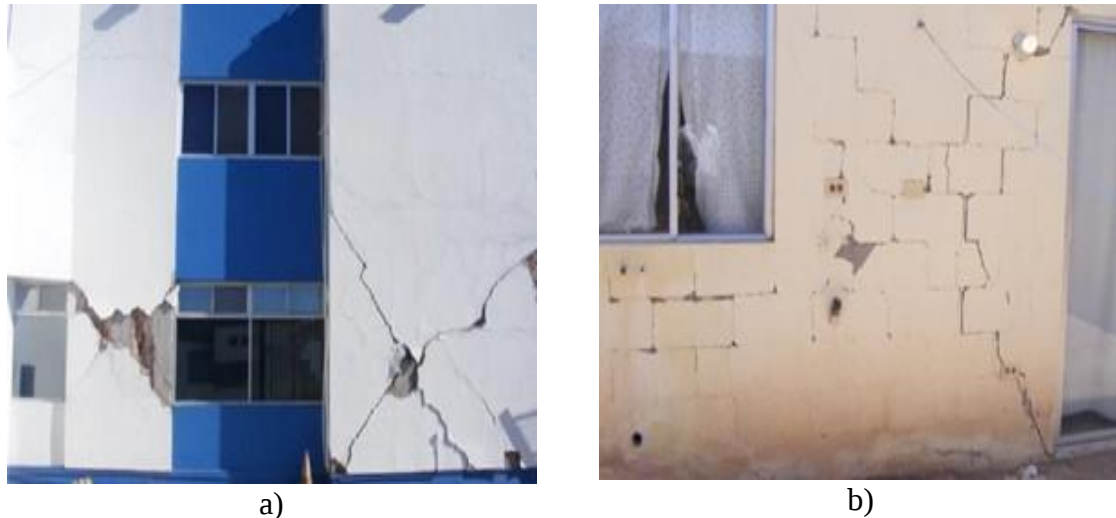
Figura 1. Danos às paredes de alvenaria no terremoto de Mexicali, na Baixa California (Martínez e Martínez, 2010): a) Paredes perimetrais curtas, b) Casa-sala
