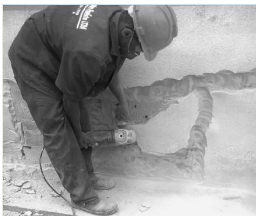
Figura 16a. Proceso de rebajado del revestimiento con piedra de amolar
