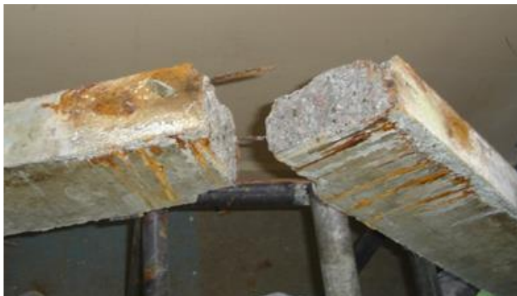
Figura 4. Viga V96 após o colapso.
