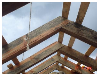
Figura 14. Vigas pares empleadas en la restauración, vista interior
