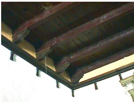
Figura 6. Sistema de viguería de la capilla del hospital de Santiago Angahuan.
