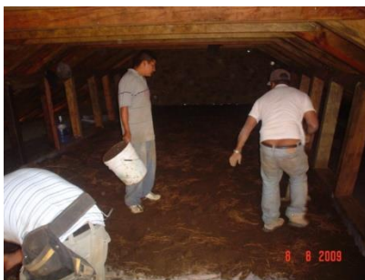
Figura 18. Colocación del terrado tradicional con arcilla roja y paja o huinumo.
