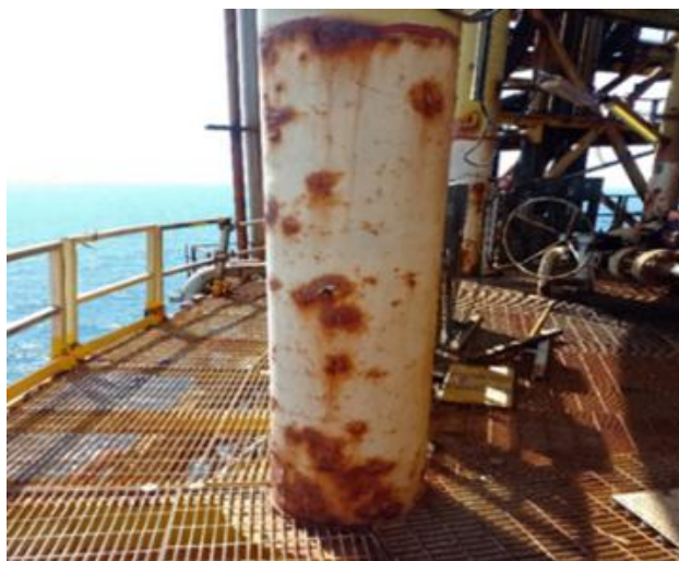
Figura 3. Corrosión alveolar.
