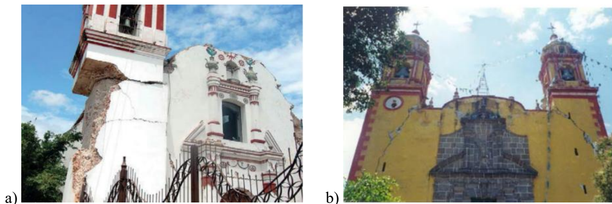
Fig. 1. Tendencia de deterioro y falla en torres campanario adosadas a cuerpos adyacentes, a) falla horizontal por sismo con tendencia al volteo en la parte superior por cambio abrupto de volumen. Imagen retomada de Secretaría de Cultura, Gobierno de México (2024), b) falla diagonal por sismo por cambio abrupto de sección. Imagen retomada de: De la Torre R. O., et. al. (2004).
