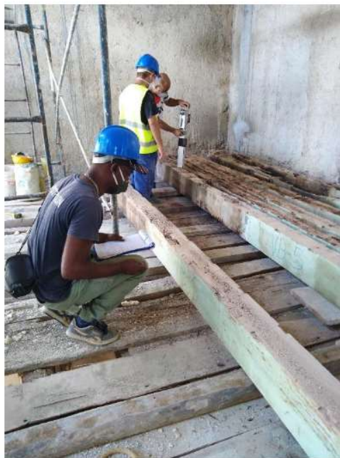
Figura 4. Inspección y clasificación visual de vigas desmontadas
