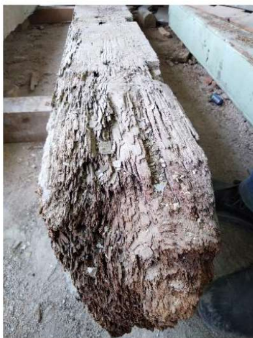
Figura 5. Estado de las cabezas de las vigas
