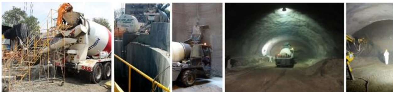
Figura 1. Procedimento para aplicar o revestimento primário do túnel L-12
