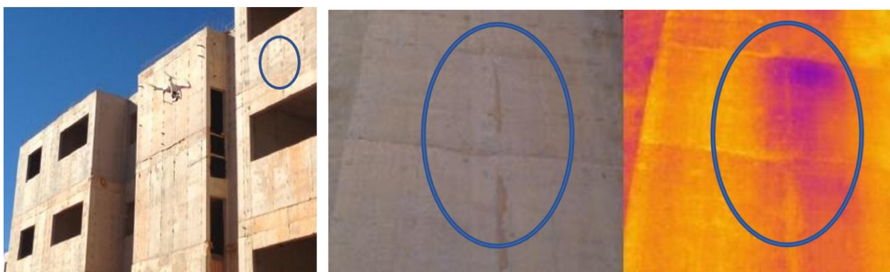
Figura 5. Inspeção com VANT integrado com câmera térmica (Nascimento, 2014)
