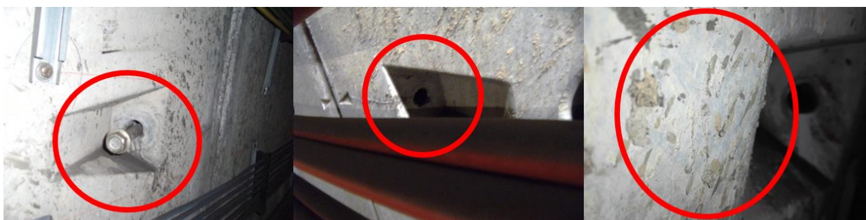
Figura 6. Rugosidade e parafusos de fixação que podem afetar a colocação da fibra.
