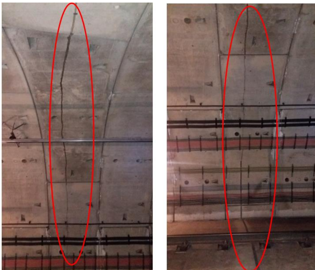
Figura 11. Procedimento de aderência de fibra ótica na laje da via 2 e na abóbada do túnel.
