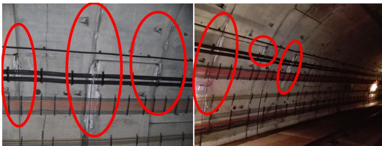
Figura 5. Filtraciones (lixiviaciones de las cales del cemento).
