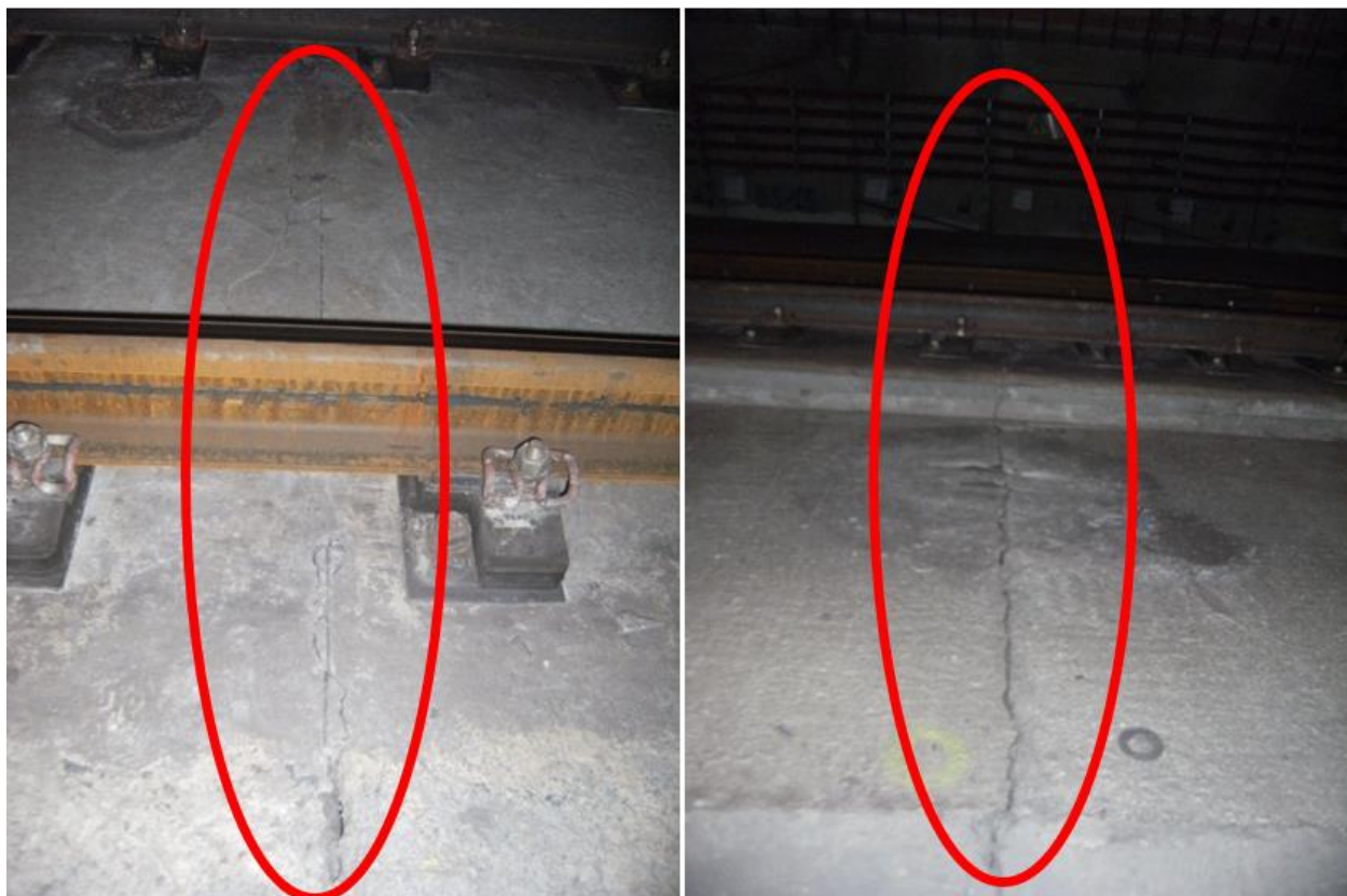
Figura 4. Juntas en la losa de vías, que existen cada 25m.
