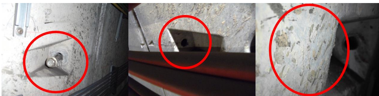
Figura 6. Rugosidad y pernos de sujeción que podrían afectar a la colocación de la fibra.
