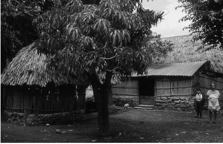
FOTO 4. Cocina con muros de colox-che sin embarro de planta absidal (izquierda); estructura de planta rectangular con muros de bajareque y baño adosado a su lado derecho, la estructura rectangular está adosada a la estancia de bajareque de planta absidal (centro y derecha); estructuras separadas distribuidas al centro del solar. Poc-boc, Campeche
