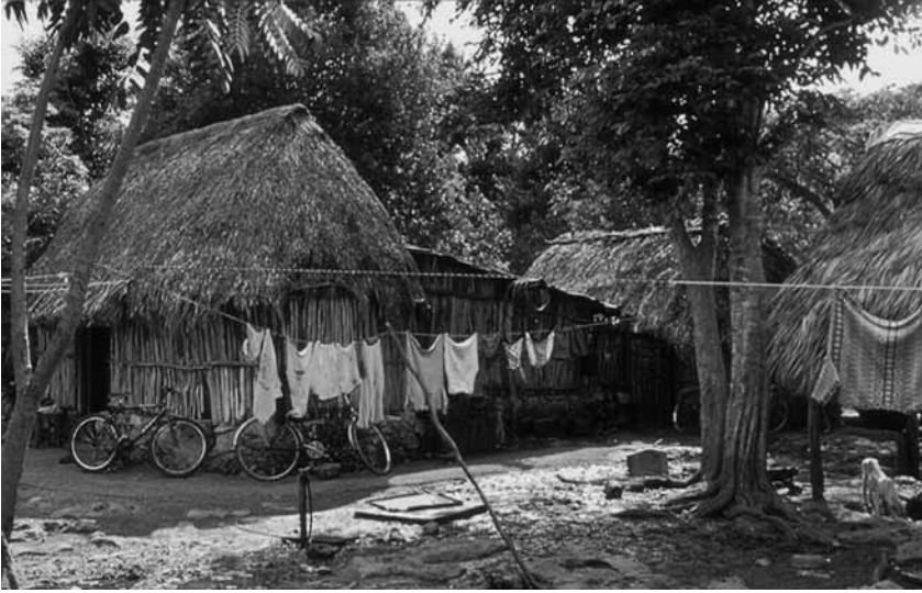
FOTO 2. Vivienda de bajareque de planta absidal con estructuras adjuntas distribuidas al centro del solar. Nunkiní, Campeche
