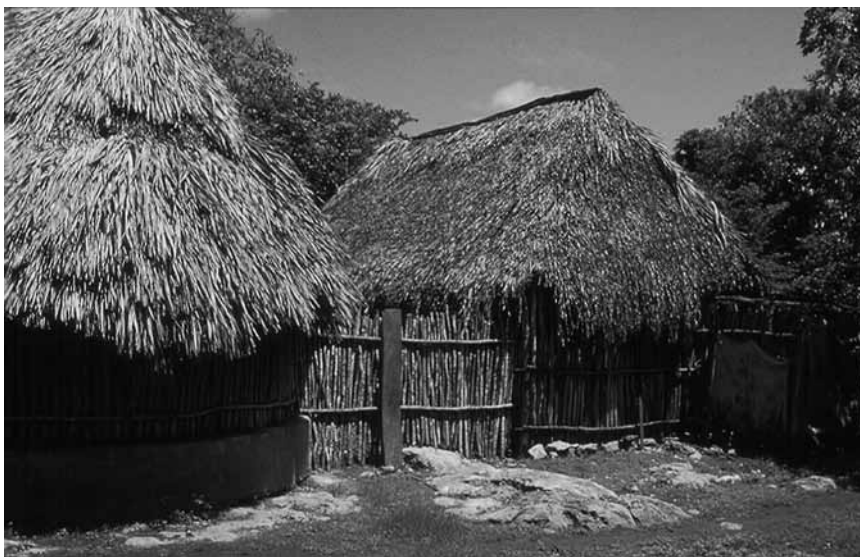
FOTO 6. Vivienda de colox-che' sin embarro de planta rectangular (derecha); vivienda de bajareque de planta absidal (izquierda); estructuras separadas distribuidas al centro del solar delimitando el espacio abierto con una empalizada. Tenabo, Campeche
