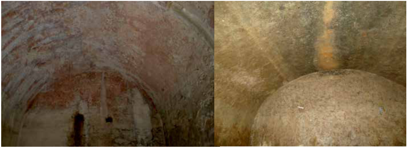
FIGURA 6. Comparativa de bóvedas. Aljibe medieval en Teruel, España (izquierda). Bóveda en los espacios en estudio, en Mérida, Yucatán (derecha) (Imagen izquierda: Casado, 2017; fuente: [www.turismoespana.es], 2017; Imagen derecha: Eduardo Cerón, 2017; cortesía: Universidad Modelo/ Proyecto San Juan, 2017).
