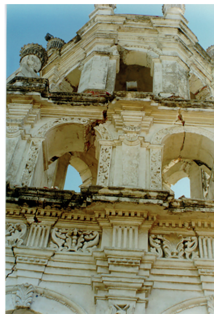
FIGURA 5. Grietas en la torre norte del templo de la Compañía de Jesús (Fotografía: Acrosa, 1999; cortesía: Empresa constructora Acrosa).
