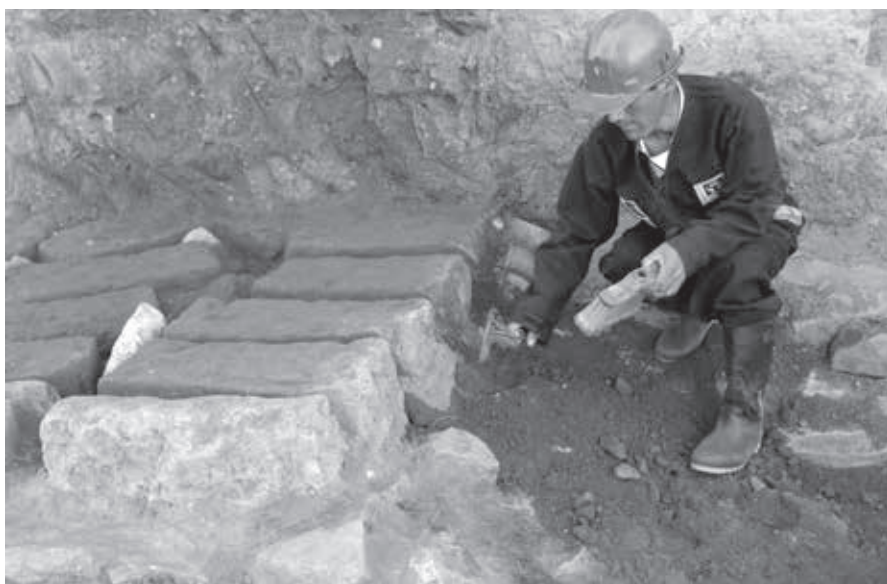
FIGURA 3. Un trabajador fabrica adobes para la rehabilitación de la iglesia de Santa Clara, Pomacocha, Perú (Fotografía cortesía: A-RSF).
