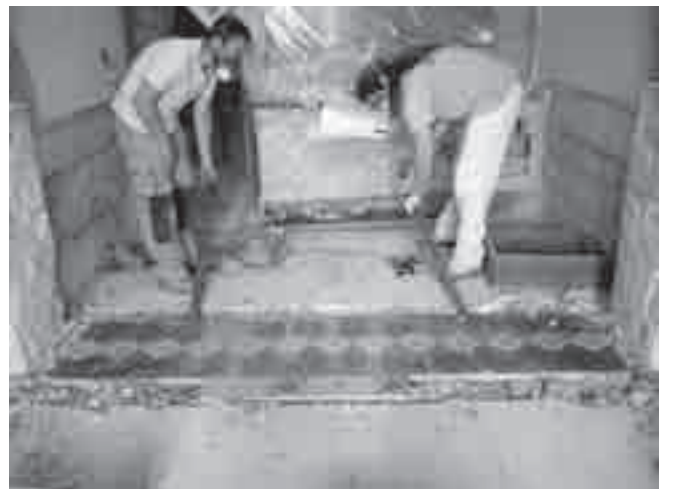
FIGURA 2. Con ayuda de palancas, una vez realizadas las regatas o canales periféricos, se levantan las secciones del suelo decoradas con las cerámicas vidriadas (Fotografía Rodrigo Surell 2010, cortesía: Agora).
