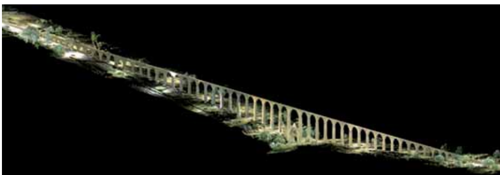
FIGURA 6. Imagen en nube de puntos láser con fotografía de la arcada monumental del Acueducto del Padre Tembleque, en la Barranca de Tepeyahualco, 2010. (Cortesía: LIAD, CNMH-INAH).
