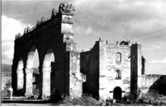
FIGURA 2. Detalle del ex convento de San Francisco Tepeyanco, Tlaxcala, antes de su restauración. Destaca el estado de abandono del conjunto arquitectónico. En la zona inferior derecha se observa el panteón que durante la restauración de 1990 se removió y convirtió en jardín (Fotografía: s. f., siglo XX; cortesía: Archivo de Restauración del Centro INAH Tlaxcala-Instituto Nacional de Antropología e Historia [INAH], México).
