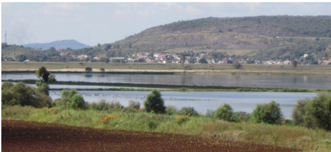
Figure 1. Spate irrigation system boxes in Huaniqueo, Michoacán, Mexico (October 2016). Figura 1. Cajas para entarquinamiento en Huaniqueo, Michoacán, México (octubre de 2016).
