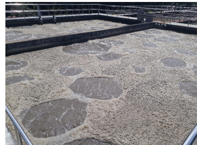
Figura 1. Tanque de lodos activados. Fuente: Autor
