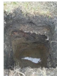
Figura 11. Calicata practicada en Zona 1. Nivel freático a 3.50 m
