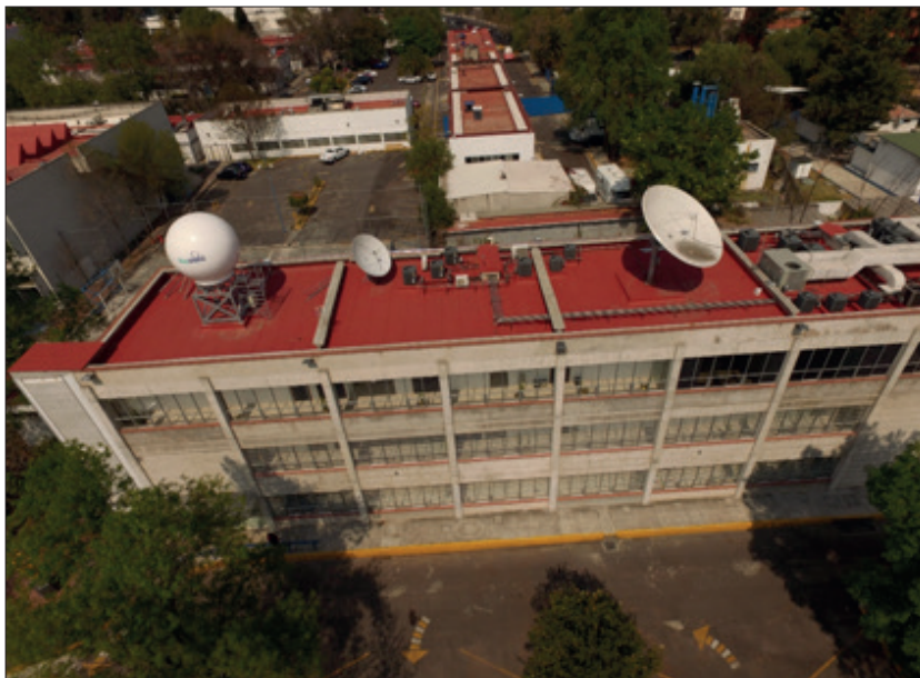
Figura 1. Antenas receptoras de imágenes a) satélite Geoestacionario GOES-16 (derecha); b) satélites de órbita polar (izquierda); c) Imágenes procesadas GeoNetCast (centro).
