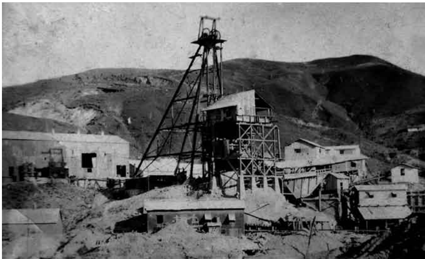
Figura 25 Vista del pozo # 1
