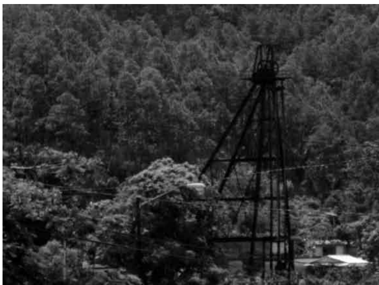
Figura 26 Vista actual del pozo #1
