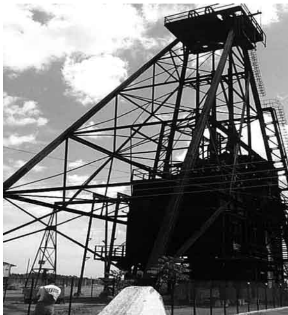
Figura 27 Vista actual del pozo #2
