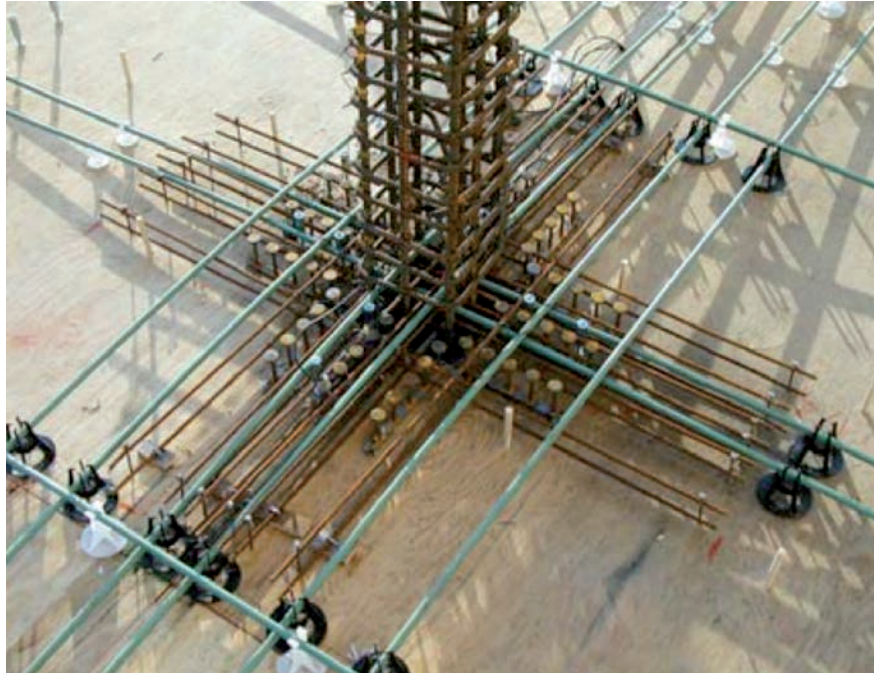
Fig. 9. Conexión interior reforzada con SSR (Kang, 2004).
