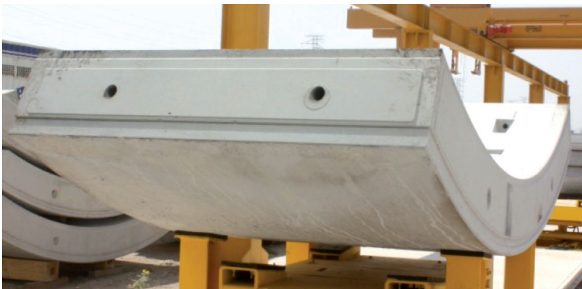
Fig. 2. Junta plana típica de una dovela.
