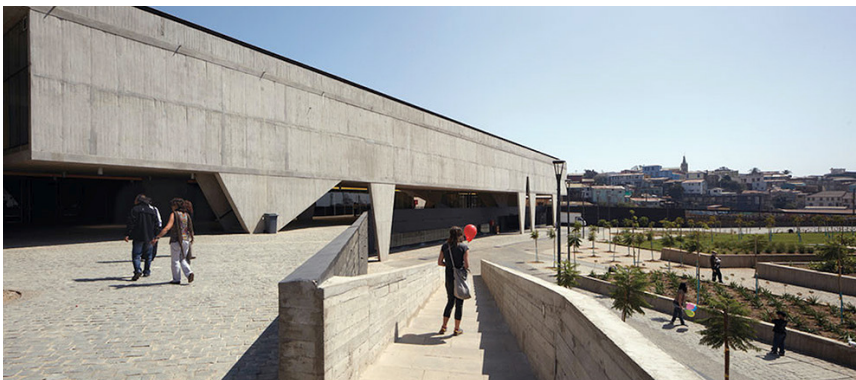
Figura 7. Centro de Exposiciones en el Parque Cultural de Valparaíso - Ex Cárcel, diseño de la oficina de arquitectos HLPS.
