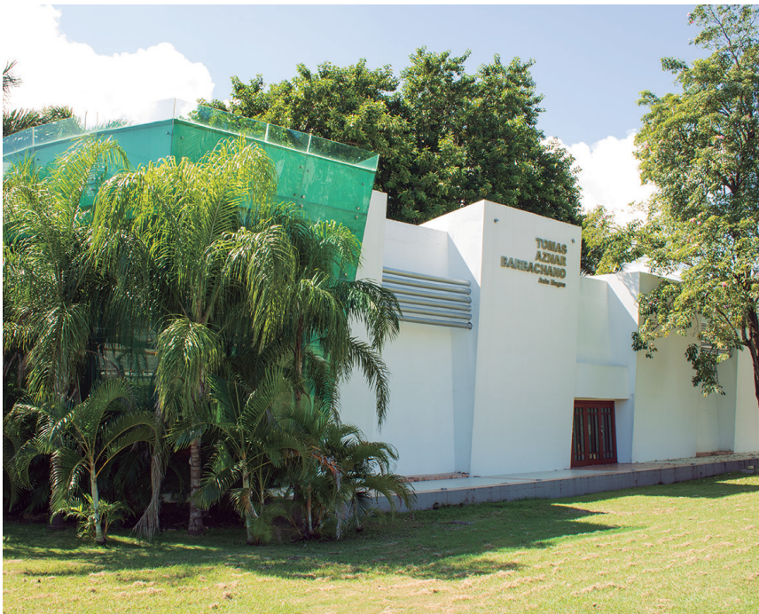
Figura 9. Fachada noroeste del Aula Magna (2022).
