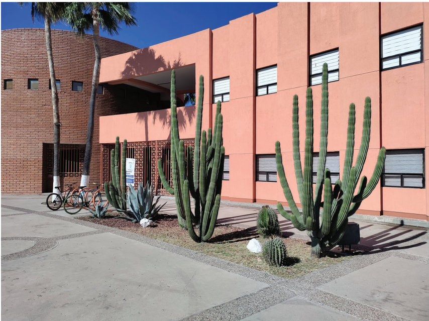
Figura 11. Uso de vegetación xerófila como elemento de jardinería y paisaje en el edificio del Departamento de Arquitectura y Diseño, Centro de las Artes, Unison (2022). Fuente: Colección del autor.
