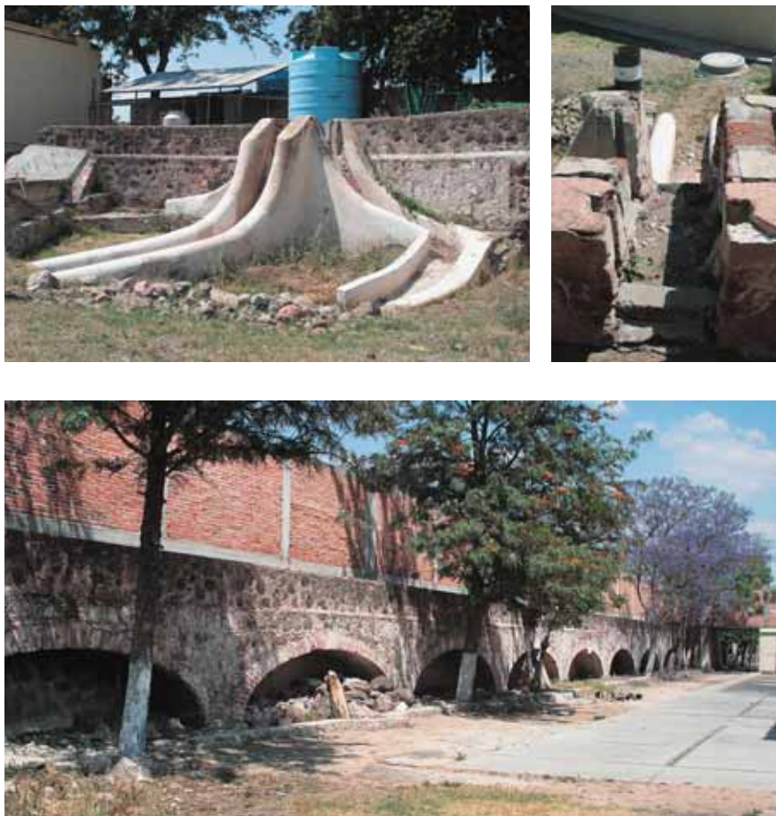
11. Acueducto. Fotos: Andrés Torres Acosta, febrero de 2007.
