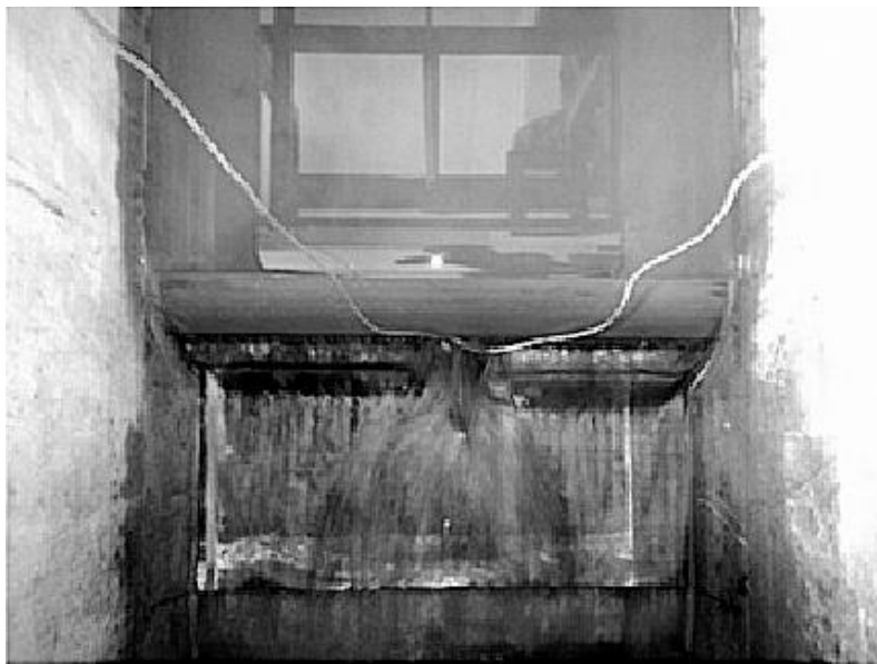
Figura 8. Cimacio ventilado mediante mangueras.
