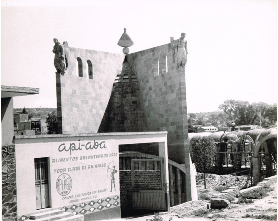
IMAGEN 11. DETALLE DE LOS ARCOS BOTARELES Y ESTATUAS, DESDE LA CALLE, DEL REFUGIO PARA PEREGRINOS
