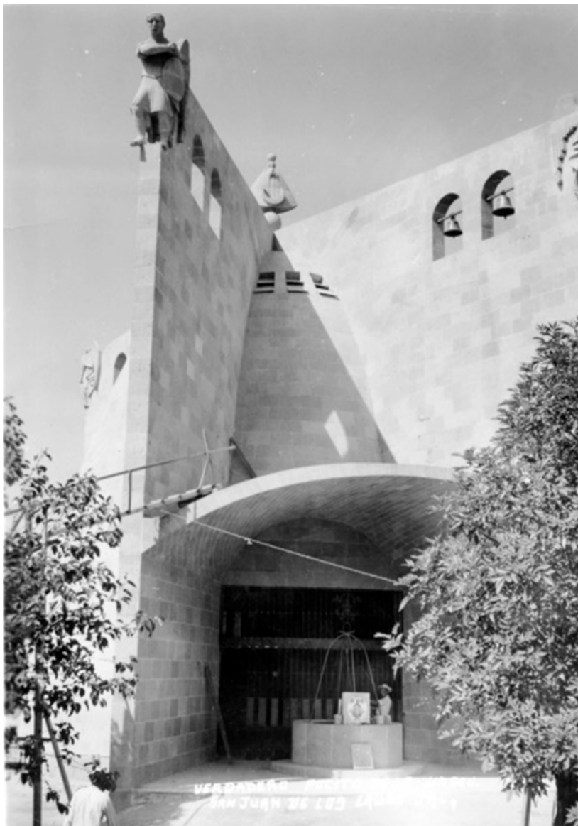
IMAGEN 4. DETALLE DE LOS ARCOS BOTARELES Y ESTATUAS, CON VISTAS AL POZO, DEL REFUGIO PARA PEREGRINOS
