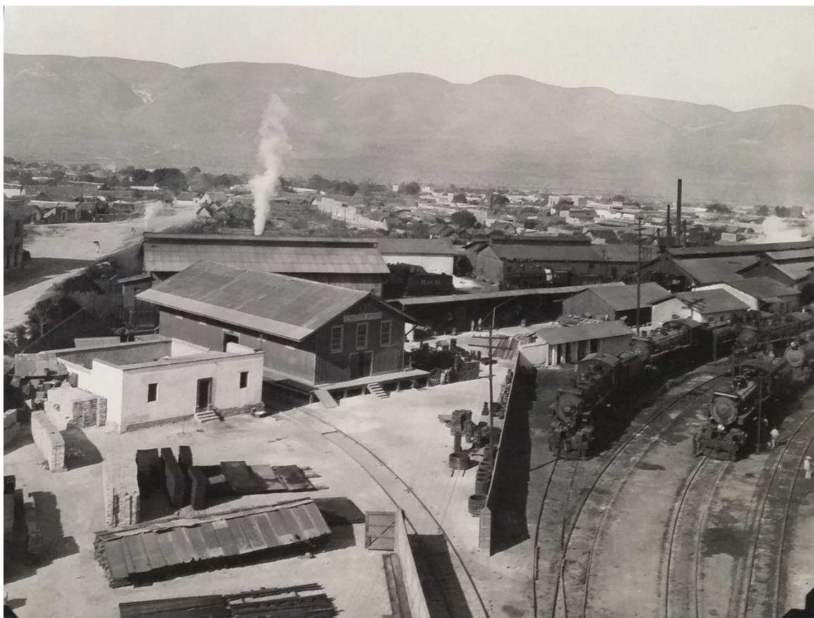
Figura 1. Estación de Cárdenas, San Luis Potosí.
