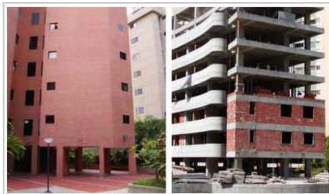
Figura 1. Ejemplos de estructuras con piso suave, planta baja con marcos de concreto y niveles superiores con muros de mampostería ( http://www.ingcivil.org )
