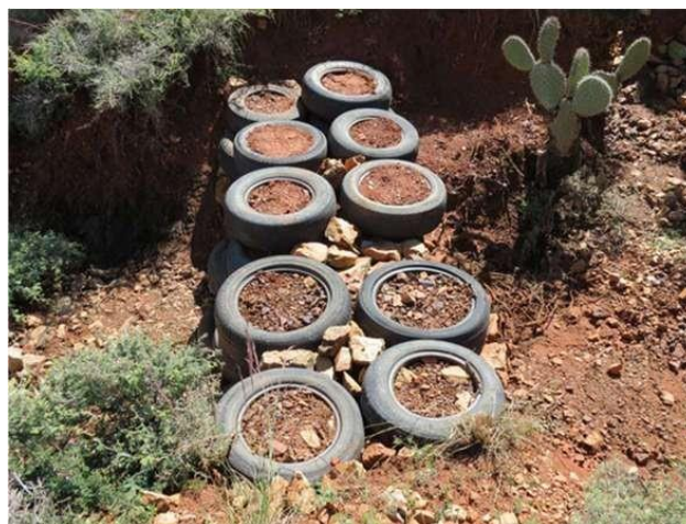
Figura 13. Presa de llantas, caso 3. Fuente: CONAFOR, 2015.
