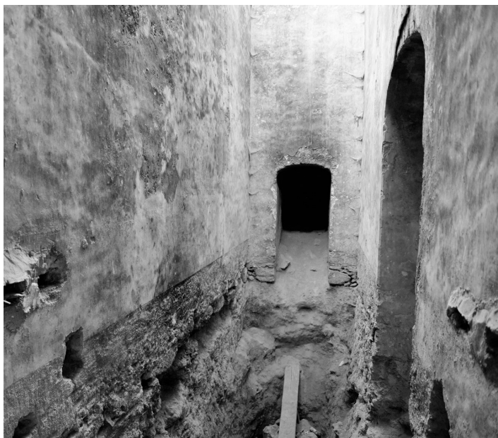
FOTOGRAFÍA 4. INTERIOR DEL POZO DE JESÚS MARÍA DONDE SE MUESTRA LA DESEMBOCADURA DE DOS GALERÍAS O CANALES DE DRENAJE
