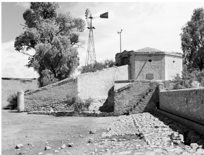
FOTOGRAFÍA 2. COMPUERTA DEL TANQUE DE PROVIDENCIA DESDE DONDE PARTE LA GALERÍA DE DRENAJE QUE RECORRE LA CORTINA HASTA CONECTARSE CON EL POZO
