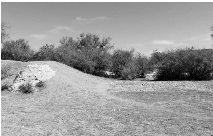
FOTOGRAFÍA 3. CONTRAFUERTE ORIENTAL DEL TANQUE Y ALIVIADERO
