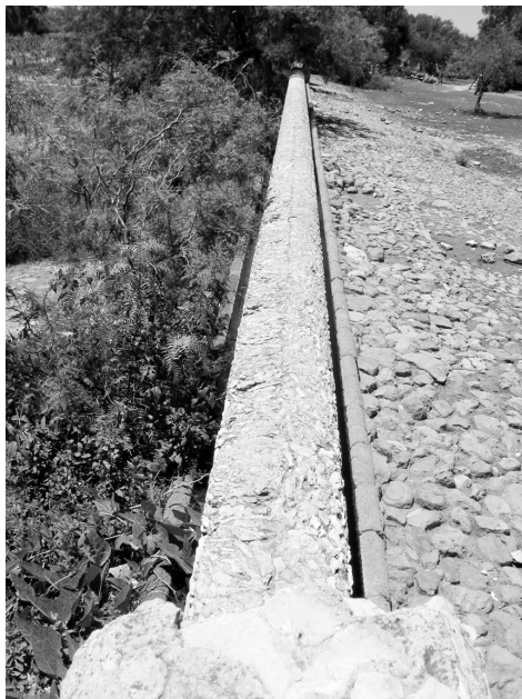
FOTOGRAFÍA 15. ABREVEDERO CON RAMPA PARA GANADO MENOR EN POZO SALADO
