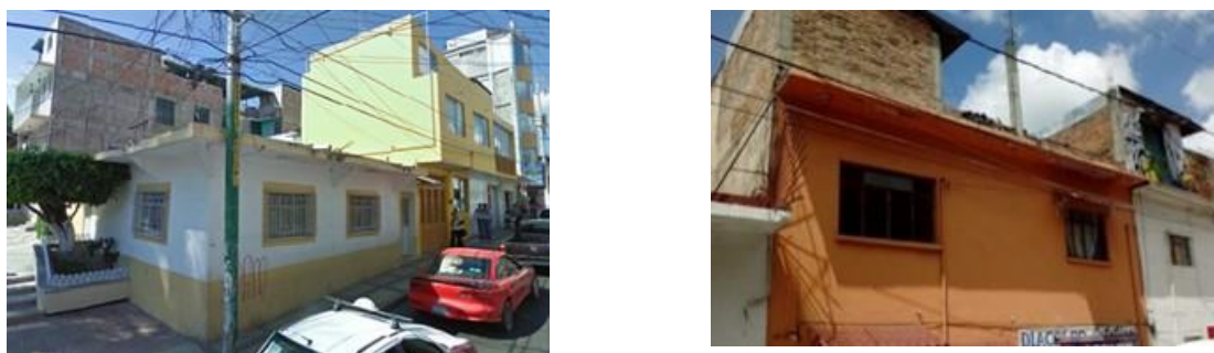
Figura 4. Construcciones típicas de mampostería confinada
