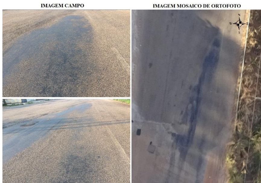
Figura 9. Exudación en el trecho próximo a la Urbanización Taquaralto.
