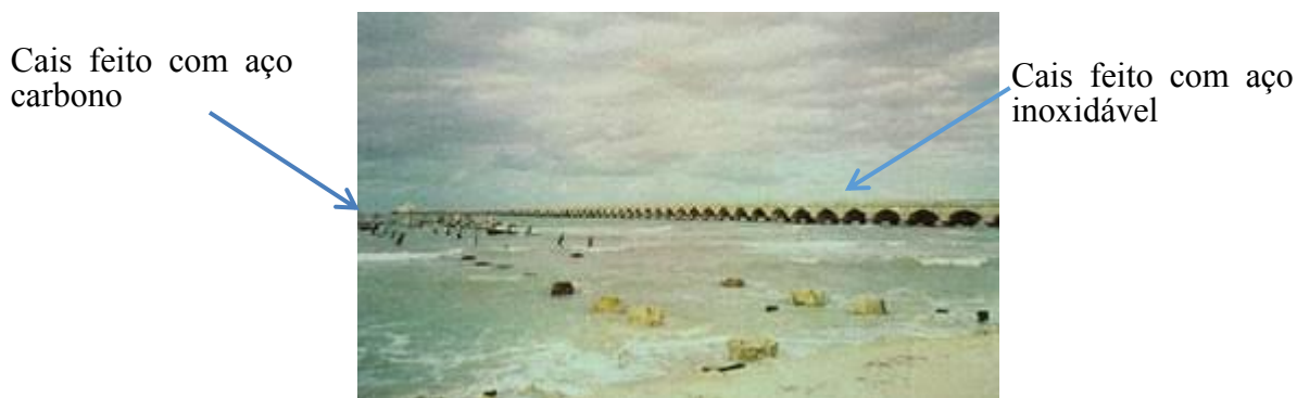
Figura 1. Comparação entre o cais feito com aço inoxidável (direita) e o cais feito com aço carbono (esquerda) (Klueh, R. L., & King, J. F. 1982).
